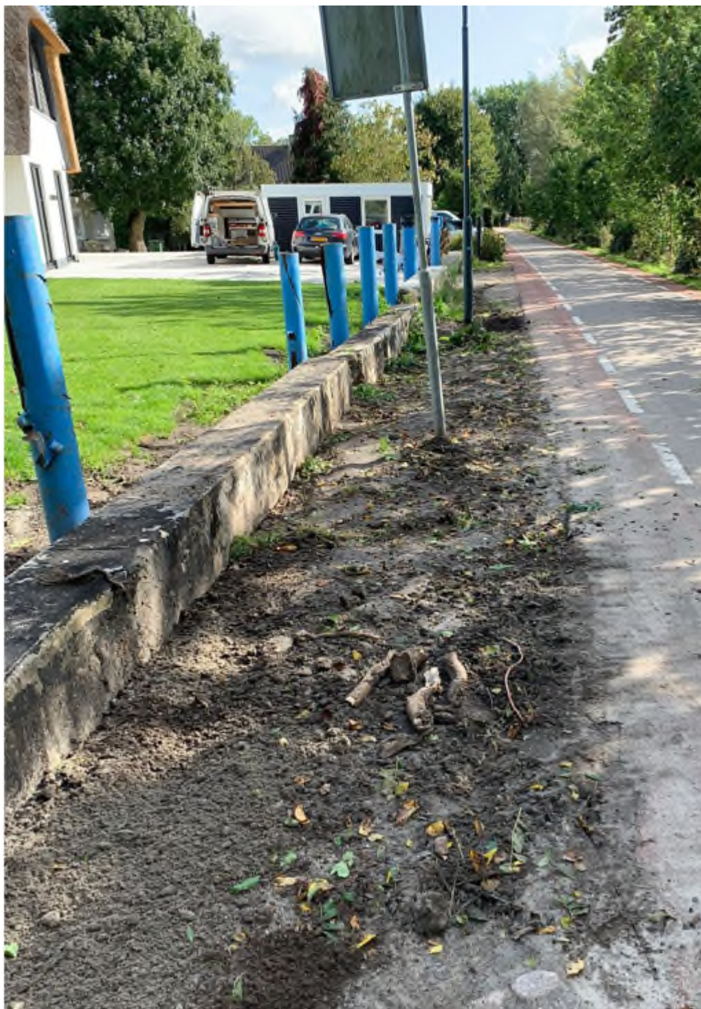
Twee foto's van de locatie met de 13 ijzeren ronde palen en de 4 betonnen liggers.
