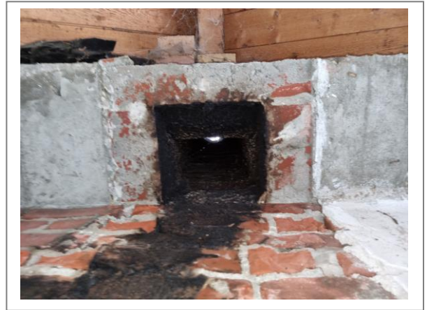
Gemetseld rookgasafvoerkanal 1 e verdieping
