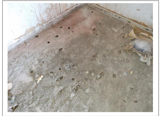
Cementdekvloer op holle bouwstenen vloer
