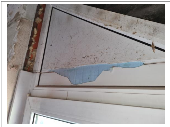
Kunststof sandwichpaneel in kunststof buitenkozijn
