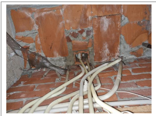
Holle bouwstenen verdiepingvloer in meterkast
