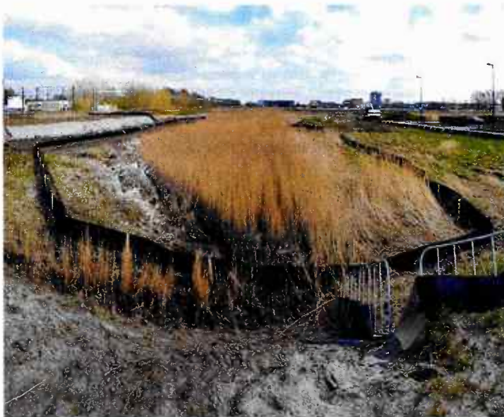
Figuur 8: Een amfibiescherm (zwart) die een poel omheind zodat de dieren niet op het werkterrein kunnen komen.
