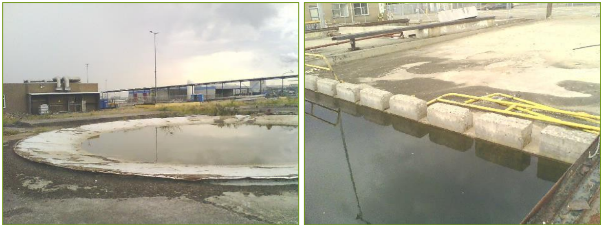
Figuur 3-5. De fundering van de gesloopte tank en het bassin gevuld met hemelwater. Foto's: RHDHV, 2020.
