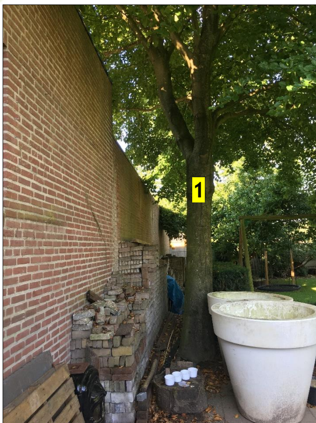
Afbeelding 7: Beuk in de achtertuin van Raadhuisstraat 48. Links de muur van het te slopen bedrijfsgebouw. Dit is tevens de gevellijn van de nieuwe semi-bungalows (hoogte 3 meter);
