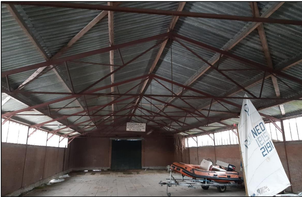
Figuur 2 De te saneren loods beschikt niet over dakbeschot waardoor nestlocaties van de huismus uitgesloten kunnen worden.
