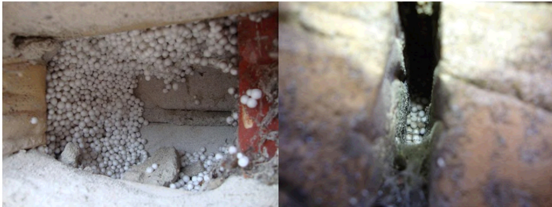
Figuur 1 De foto's hierboven geven een weergave van het plangebied en enkele details van de muurisolatie
