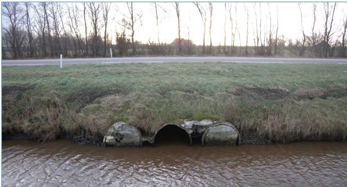
Figuur 39: Foto van dicht gezette duikers onder de N99.
