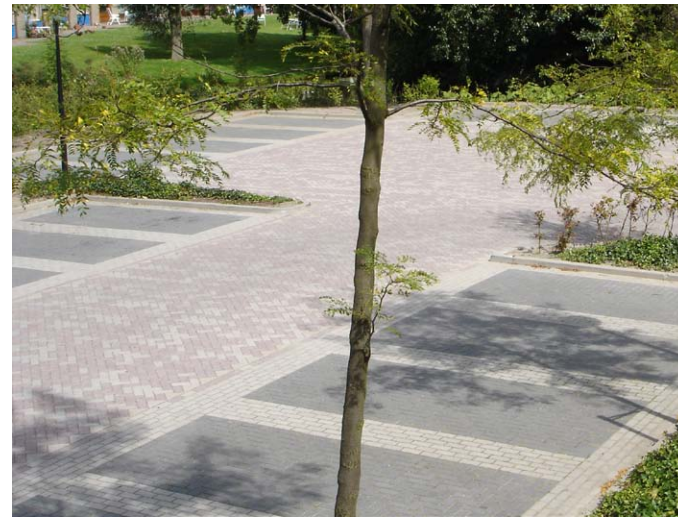
Parkeren: grijze betonklinkers in elleboogverband.
