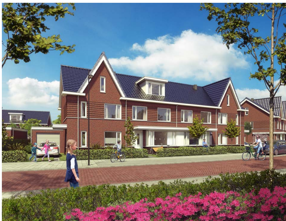
Rijwoningen vormen een ensemble. Accenten bij hoekwoningen.
