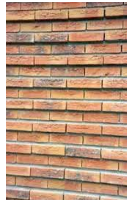
Speklagen door reliëf in metselwerk.
