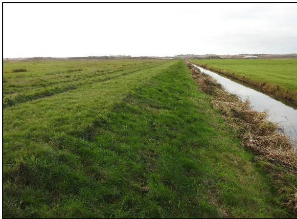
Figuur 11 – te verhogen kade aan de noordzijde
