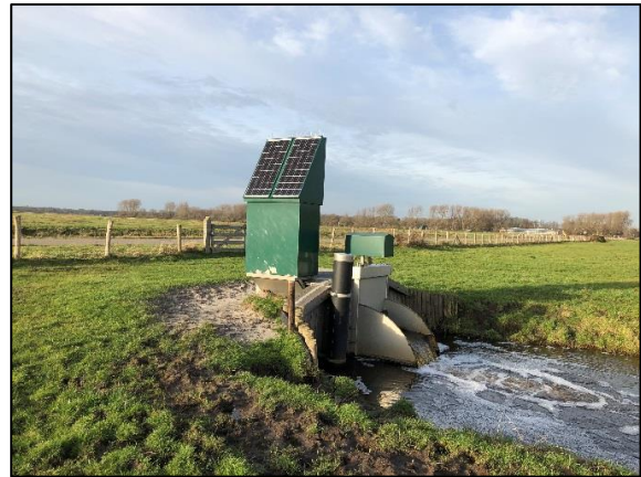
Figuur 9 – geautomatiseerde uitlaat van de berging
