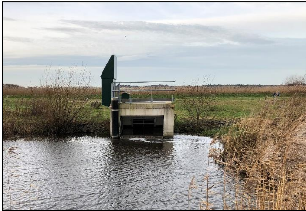
Figuur 8 – geautomatiseerde inlaat van de berging
