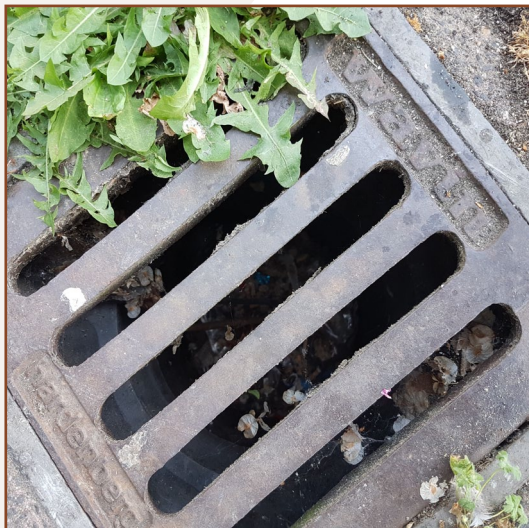
Afbeelding 9: Alle straatkolken zijn gecontroleerd en bevatten geen tongvarens of andere vegetatie.
