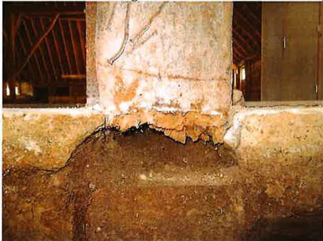
gebintstijl middelste gebint onder dak no. 1 (foto 2021)
