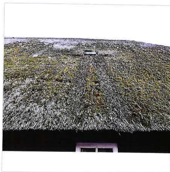
rietbedekking zeer dun geworden dak no. 1 (foto 2020)
