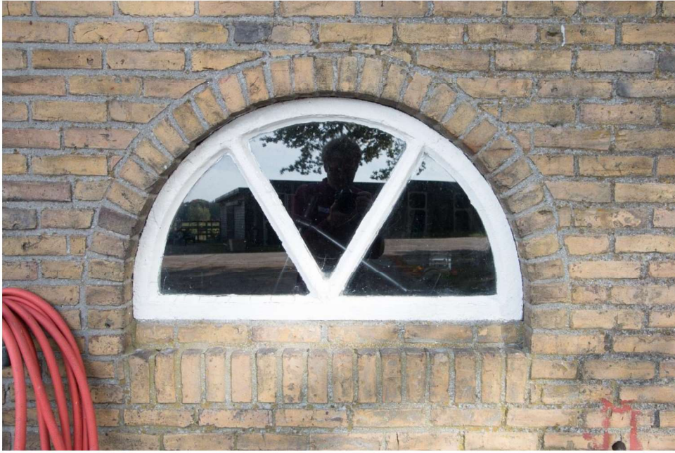
Betonnen stalraam in de achtergevel van de schuur.
