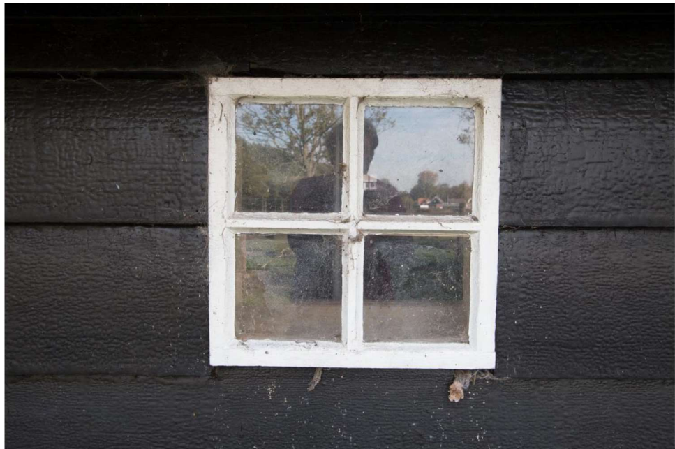
Betonnen stalraam in de rechter zijwand van de schuur.
