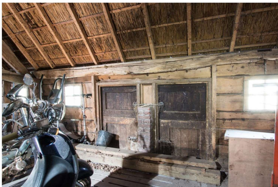
Wand rechts met twintigste-eeuwse staldeuren onder een oudere, eikenhouten wandplaat met pengaten waarmee verdwenen wandstijlen op papier kunnen worden gereconstrueerd.
