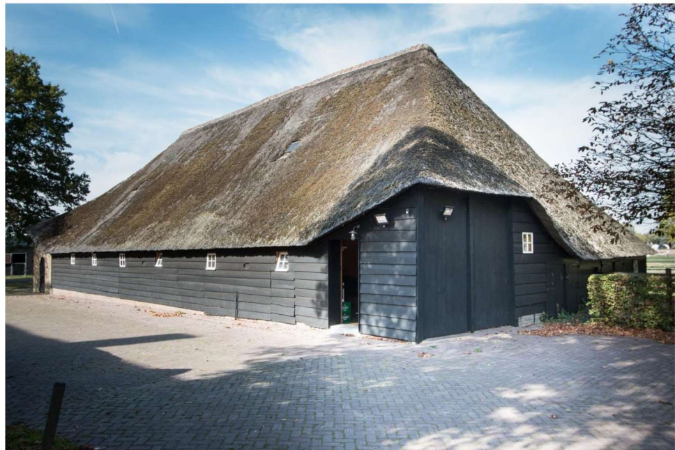
Voorzijde en linker zijwand van de schuur. Asymmetrie en deuren in voor- en achterzijde zijn de voornaamste karakteristieken van het exterieur van een Vlaamse schuur.
