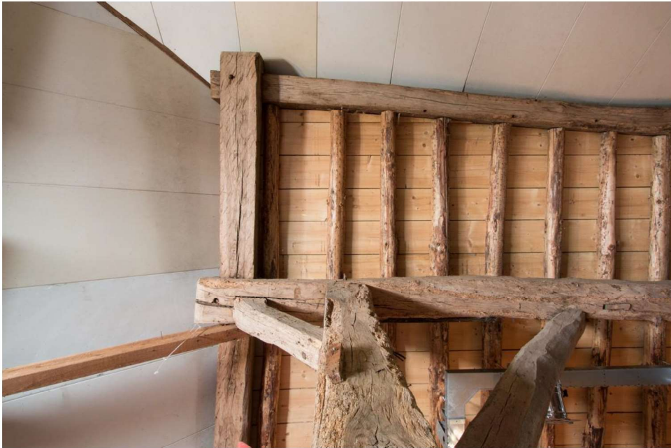
Secundaire zoldervloer ter isolatie van de ruimte.
