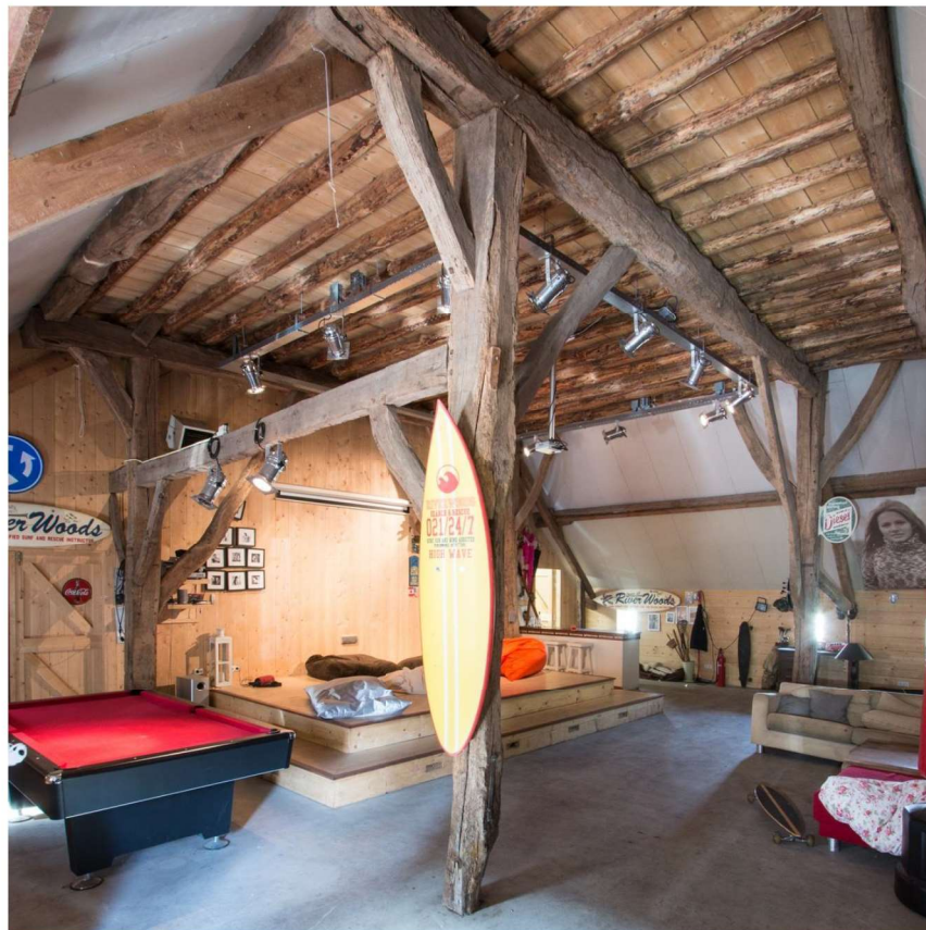
Het voorste deel van de constructie met spanten I en II. Links het overstek ten behoeve van een beladen kar. De zoldervloer is van recente datum, evenals de betonvloer.
