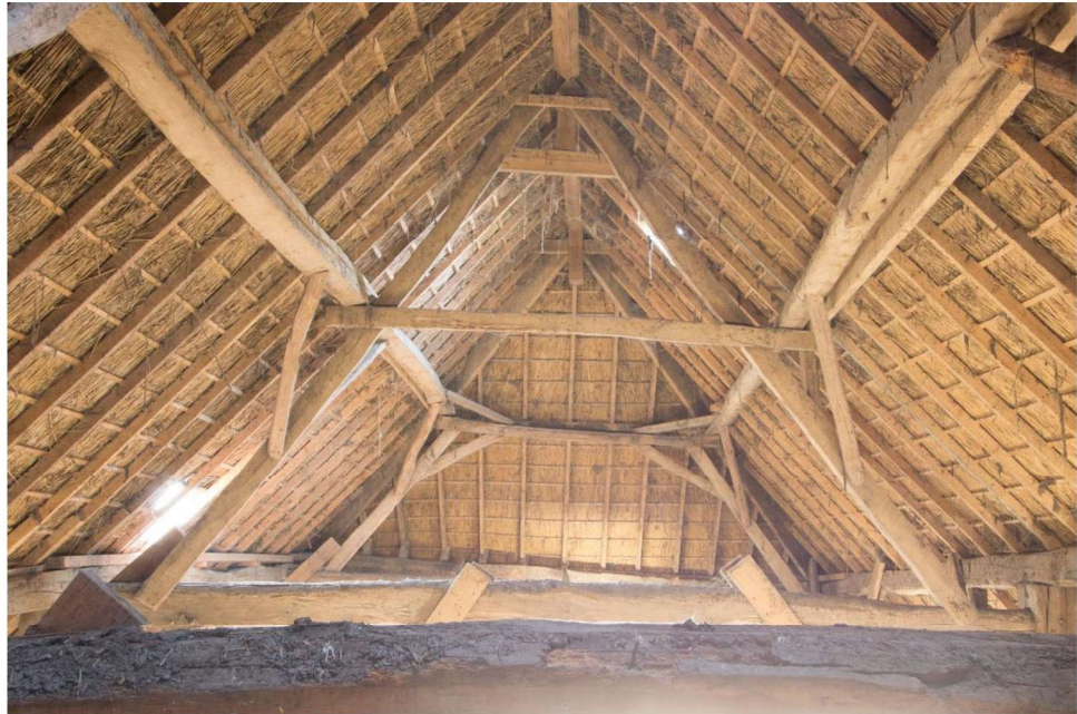
Kapspanten die later zijn geplaatst, vermoedelijk tweede helft negentiende eeuw.
