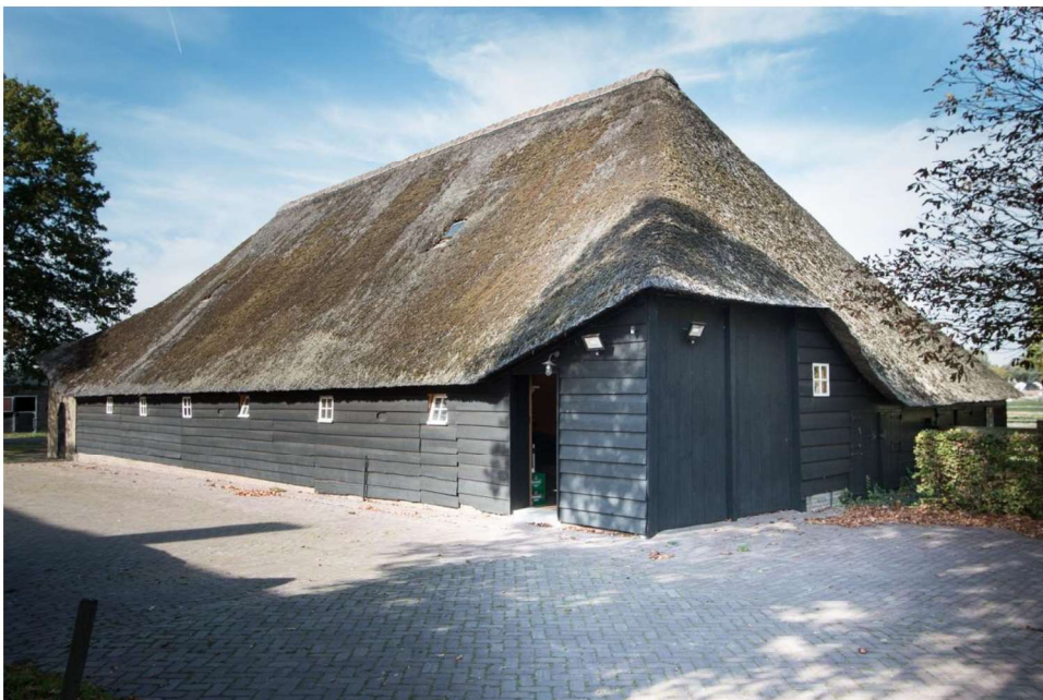
De schuur op de dag van de verkenning, voorzijde en linker zijgevel
