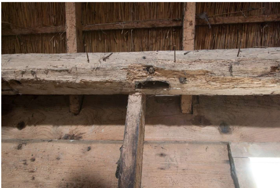
Onderzijde wandplaat met pengat voor verdwenen stijl en direct rechts daarvan een toognagel voor een verdwenen dakspoor.
