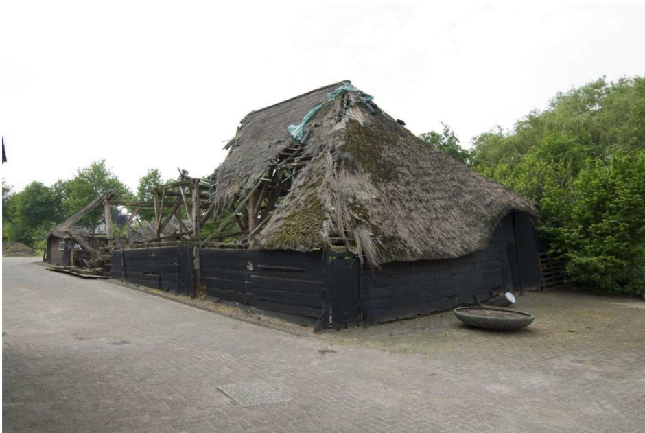
Vlaamse schuur bij Oude Beekhoek 2 vóór de herbouw (Ulvenhout, RCE)
