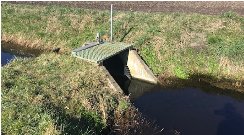
Figuur 2: Stuw 108EH wordt verwijderd. De nieuw te plaatsen stuwen zijn vergelijkbaar.
