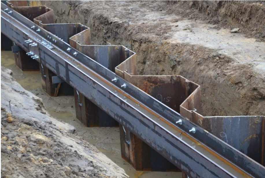
Figuur 2.62 Impressie van damwanden die als stabiliteits- en/of piping-scherm in een dijk zijn aangebracht
