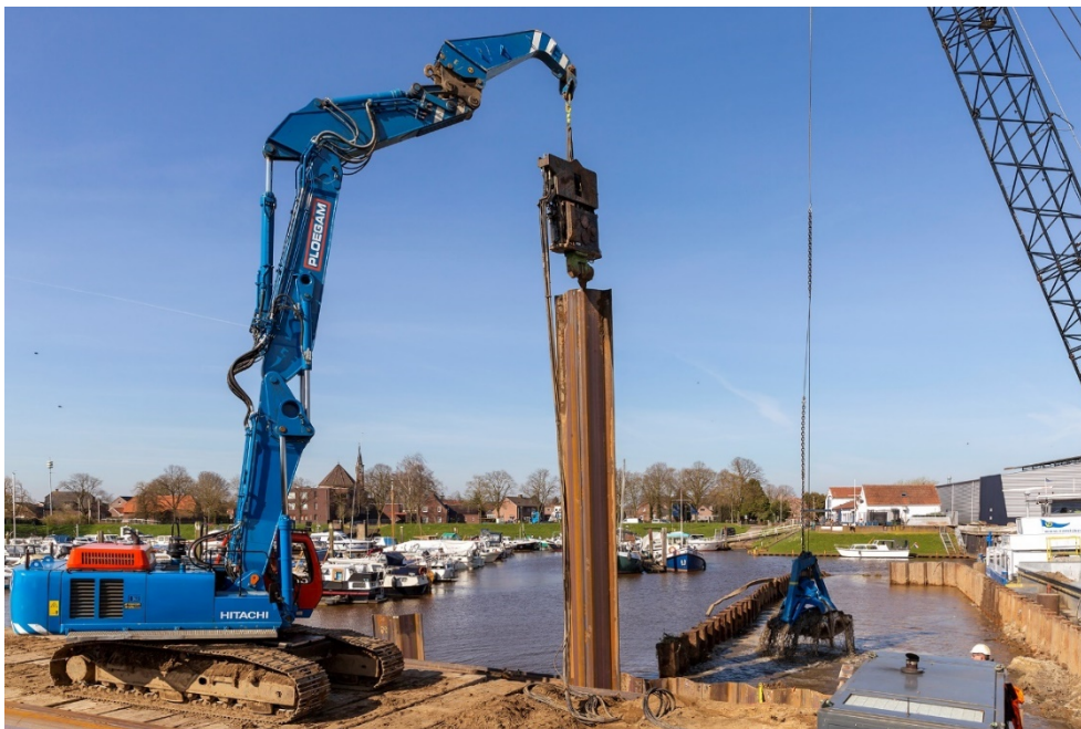
Figuur 2.61 Impressie van het aanbrengen van damwanden
