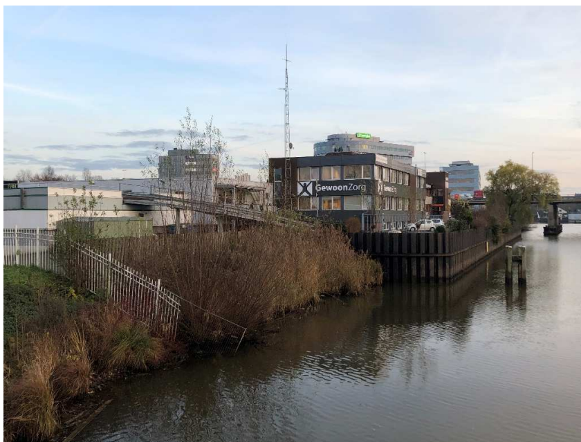
Foto 2.30 Oeverconstructie van stalen damwand en groene oever aansluiting Blaloweg
