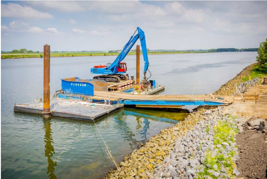
Figuur 2.64 Impressie van een tijdelijke aanlegplaats
