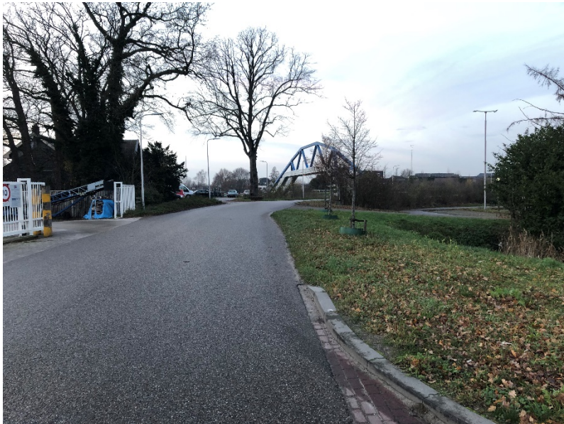
Foto 2.17 Verholen waterkering Gasthuisdijk
