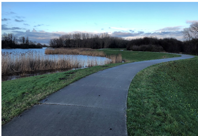
Foto 2.49 Waterkering langs de Westerveldse kolk
