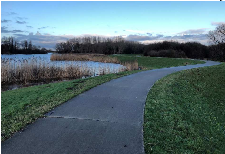
Foto 2.49 Waterkering langs de Westerveldse kolk
