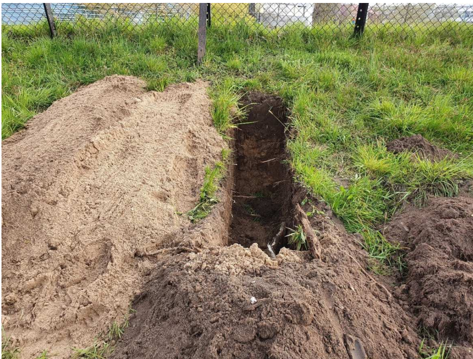
Figuur 2.57 Impressie van een proefsleuf op het bedrijventerrein van Leeman te Zwolle
