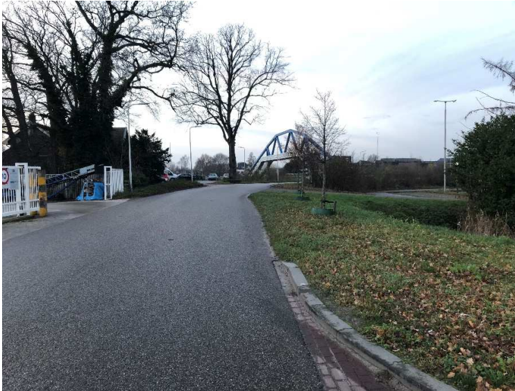
Foto 2.17 Verholen waterkering Gasthuisdijk
