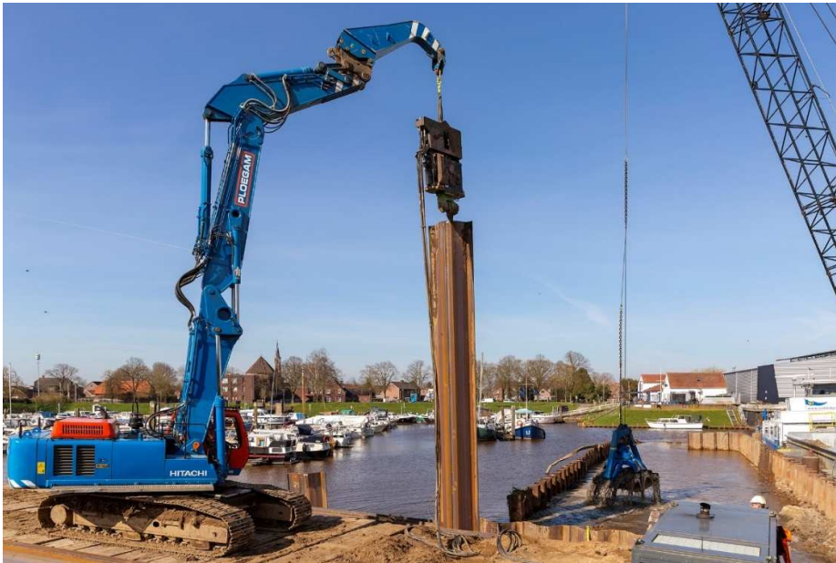
Figuur 2.61 Impressie van het aanbrengen van damwanden
