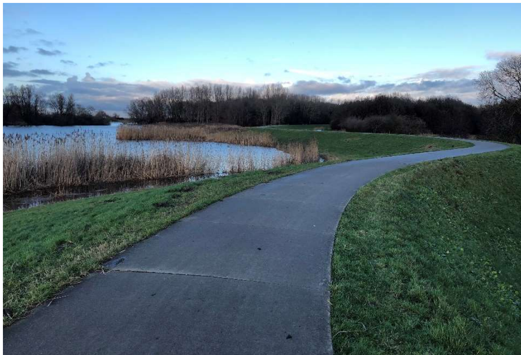
Foto 2.7 Waterkering langs de Westerveldse kolk
