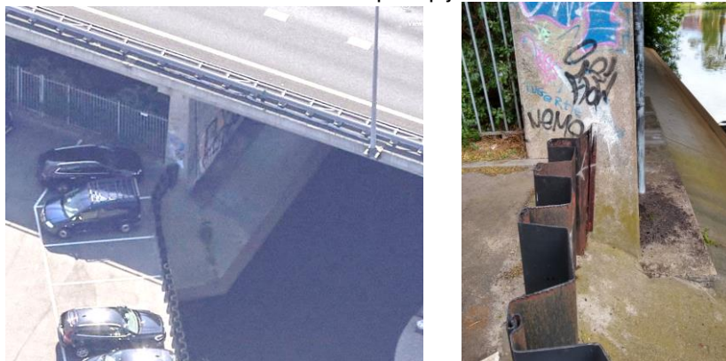
Figuur 9-4 Overzicht bestaande aansluiting damwand op pijler viaduct A28
