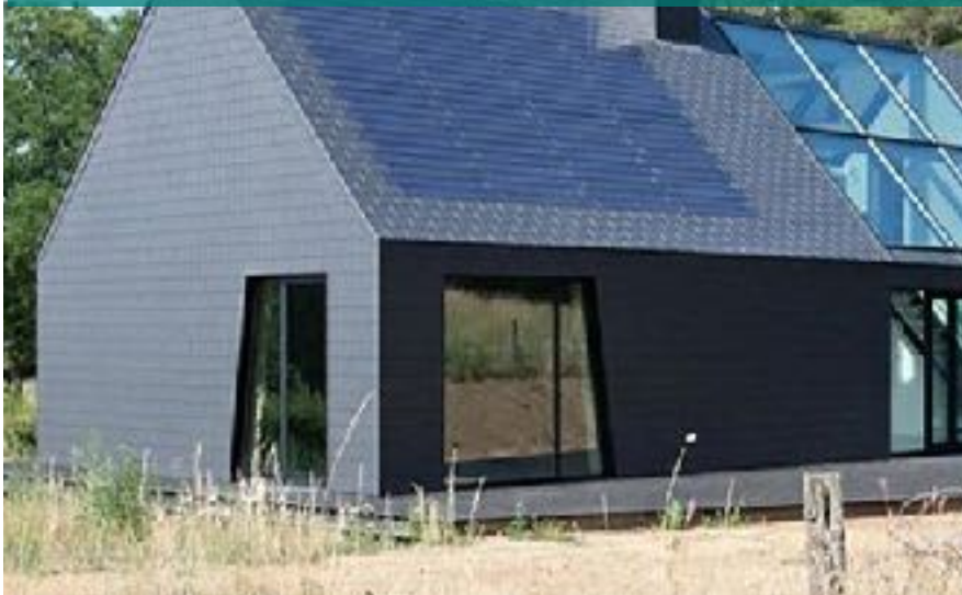
voorbeeld energie panelen geïntegreerd
