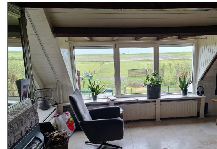
bestaande dakkapel (vernieuwen)
