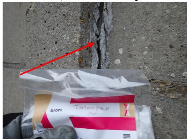
Foto 11 | Foto voor bron Afdichtingskit
