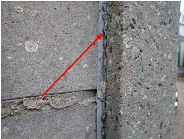
Foto 8 | Foto voor bron Afdichtingskit
