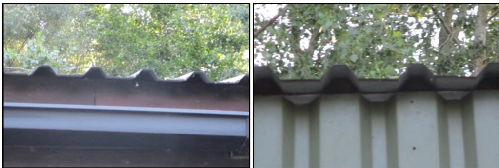
Figuur 8 Houten balken onder het dak van gebouw E maken toegang voor huismussen onmogelijk (links). Het dak van gebouw F is niet toegankelijk door het ontbreken van een structuur als een dakgoot via welke de huismussen het dak zouden kunnen betreden.
