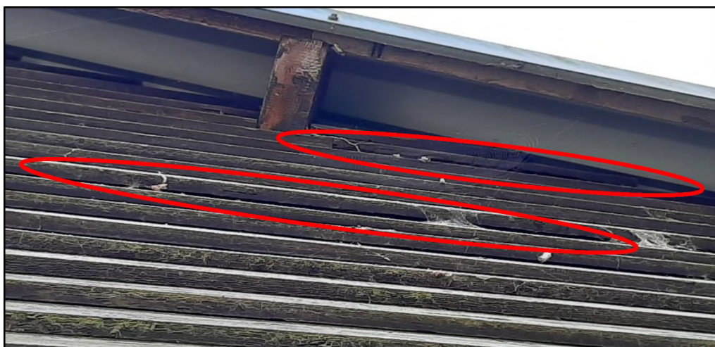
Figuur 6 Potentieel geschikte ruimtes voor vleermuis verblijfplaatsen op gebouw C (links) en gebouw E (rechts).
