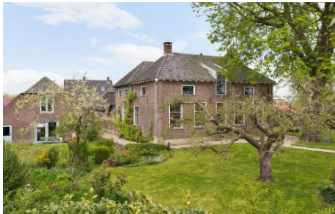
Woning uit 1825 (Maasdijk 16)
