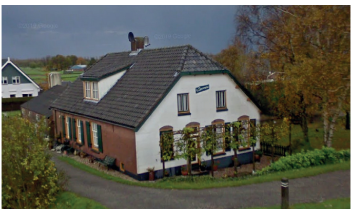
Woning uit 1860 (Maasdijk 4)
