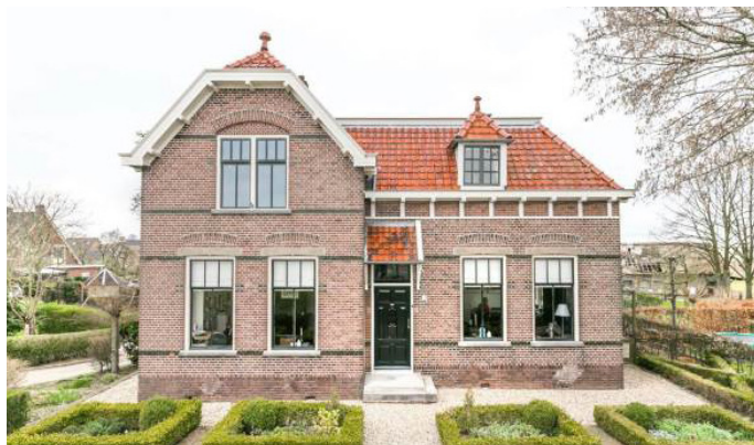
Woning uit 1912 (Maasdijk 14)
