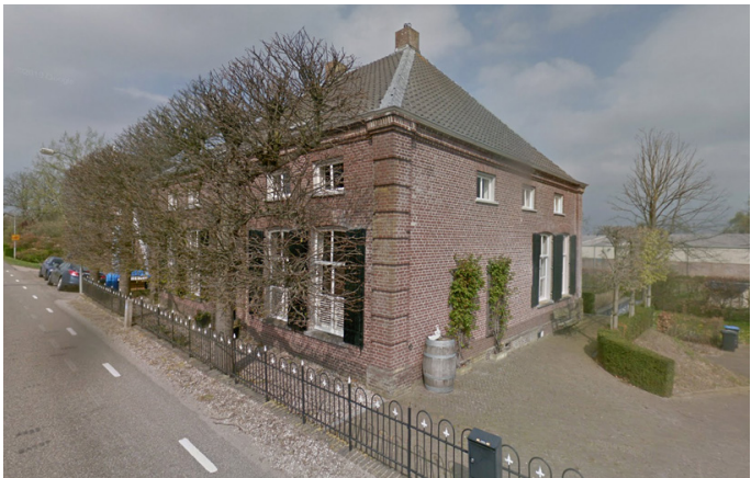
Woning uit 1825 (Maasdijk 12)
