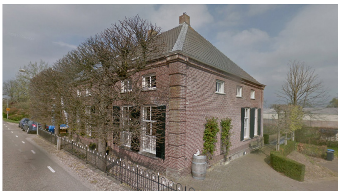
Woning uit 1825 (Maasdijk 12)
