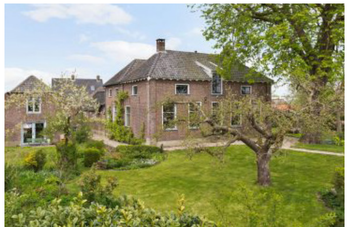
Woning uit 1861 (Maasdijk 16)
