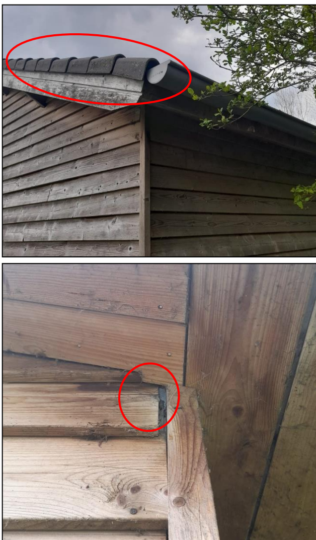
Figuur 6. De gevelpannen en gevelbeplating bieden ruimte voor vleermuizen om achter weg te kruipen.
