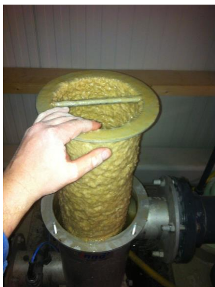
afbeelding 8.12: (voor)filter circulatiepomp
