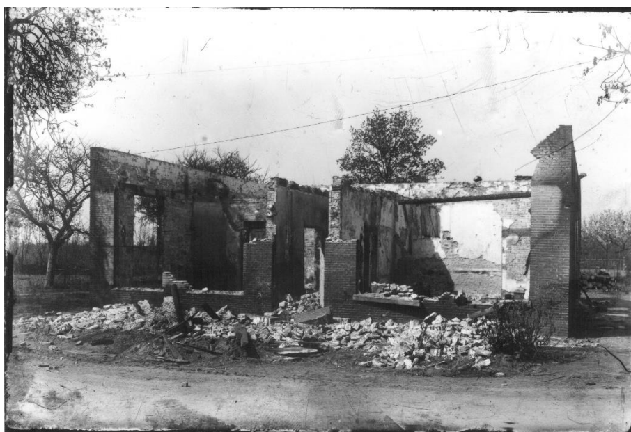
Figuur 9: Totaal verwoeste woningen aan "De Ring"
