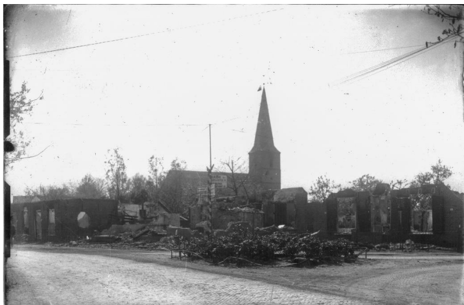
Figuur 10: Schade woningen met de Hervormde kerk op de achtergrond
