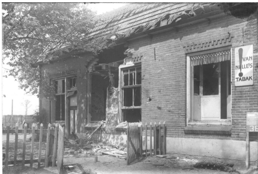
Figuur 13: Schade aan woning aan "De Ring"
