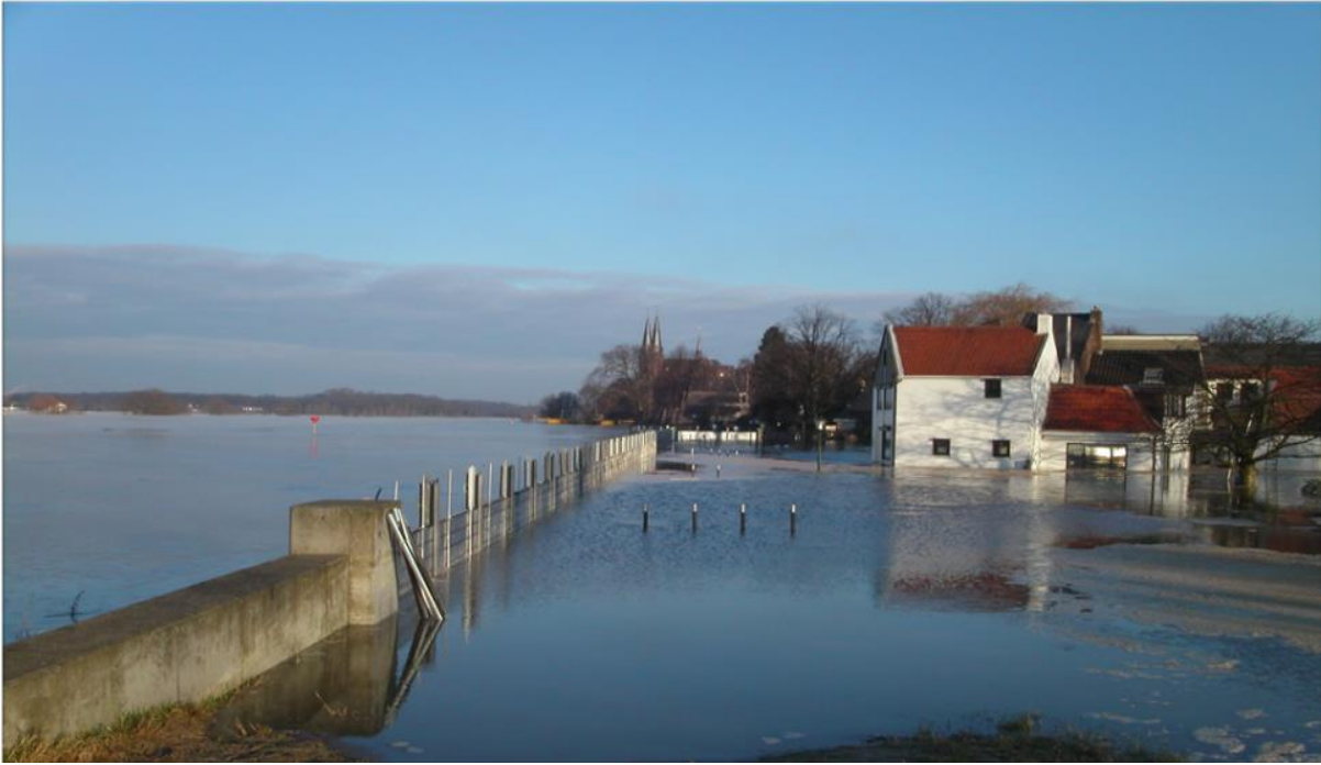
Figuur 2 De demontabele kering in Steyl-Maashoek tijdens een dijkdoorbraak
