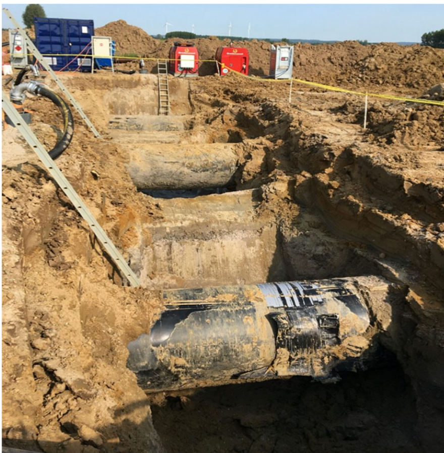
Afbeelding 6. Snij-put voor het doorhalen van de BB-leidingen (eigen foto).
