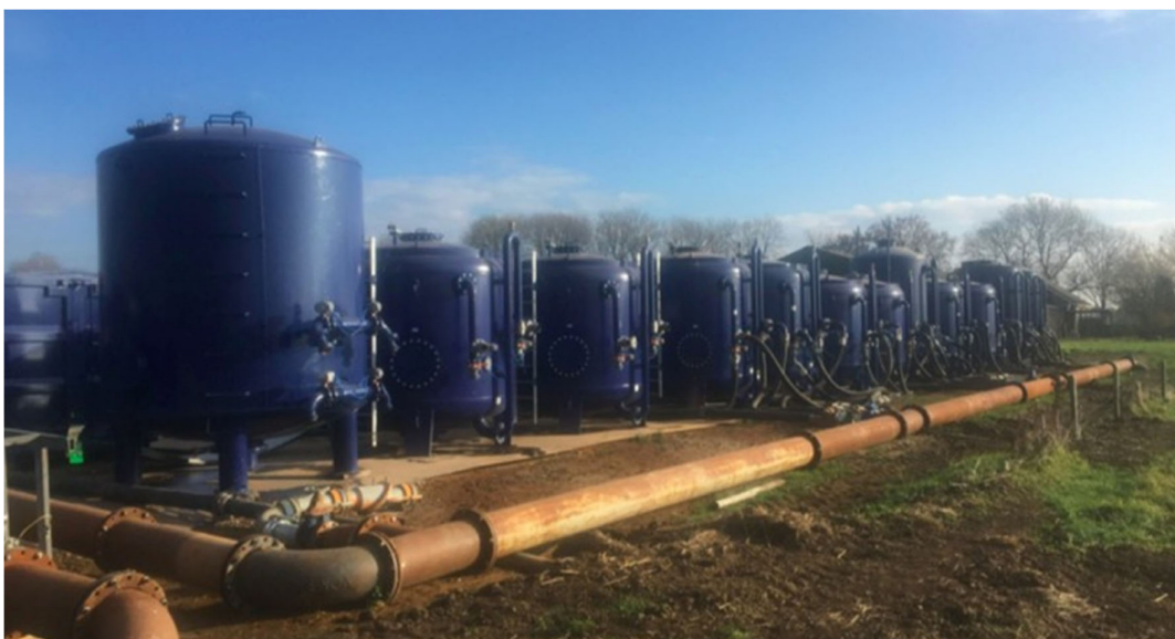
Afbeelding 21. Zandfilterinstallatie zuidzijde (Boleemweg) 750 m 3 /uur (eigen foto)
