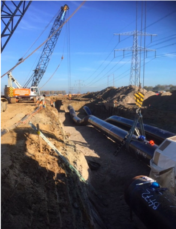
Afbeelding 4. Aanleg gastransportleidingen t.p.v. de Zevenaarse Wetering (eigen foto).
