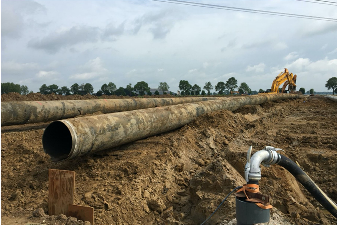
Afbeelding 7. Het verwijderen van de oude gasleidingen (eigen foto).
