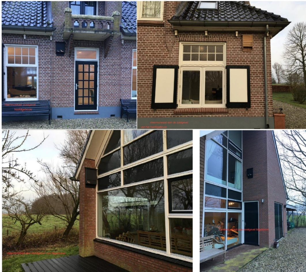
Figuur 2. Mitigerende maatregelen: oostgevel hoofdgebouw (linksboven), zuidgevel hoofdgebouw (rechtsboven), westgevel bijgebouw (linksonder) en oostgevel bijgebouw (rechtsonder).
