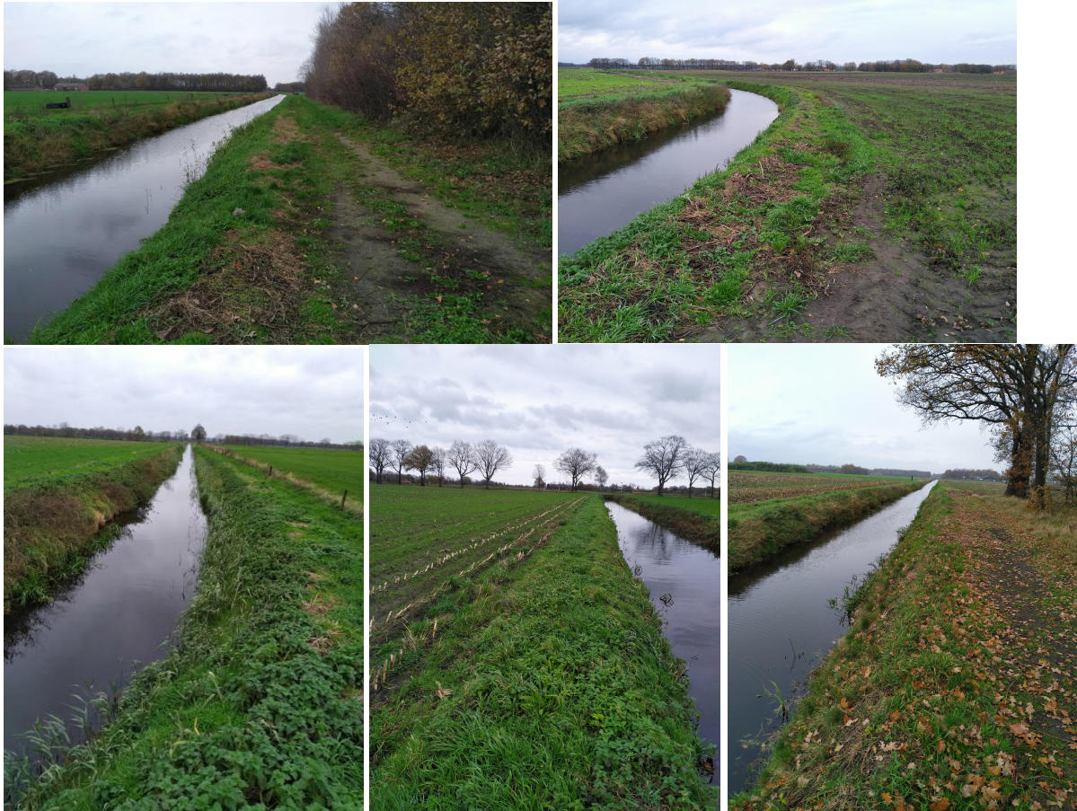
Figuur 2: Bestaande situatie Astense Aa. Met de klok mee: foto 1; rechteroever genormaliseerde loop Rechte Heitraksedijk, foto 2; ten noorden van Buizerdweg, foto 3; Astense Aa nabij Kleine Heitrak, foto 4; perceel Hoefbladweg, foto 5; Astense Aa benedenstrooms Schansweg.
