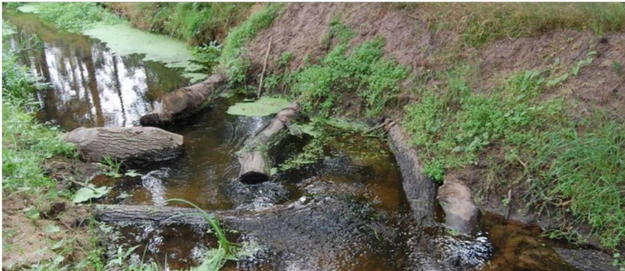
dood hout in visgraatmotief, compact aangelegd, met meer afstand tussen stammen wordt het doorstroomprofiel groter.
