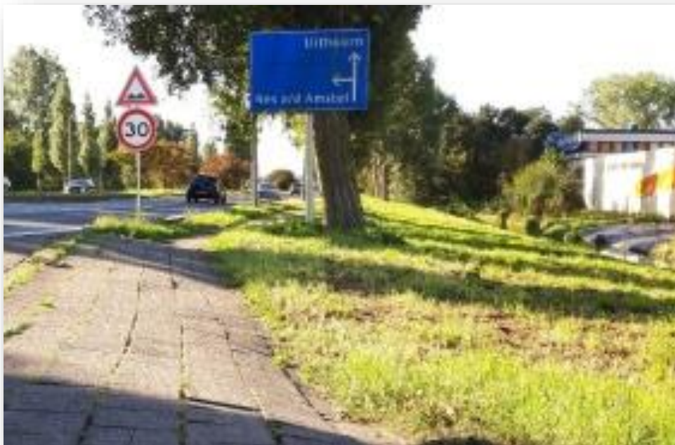
Figuur 5.4 Verzakkende verharding in Amstelveen
