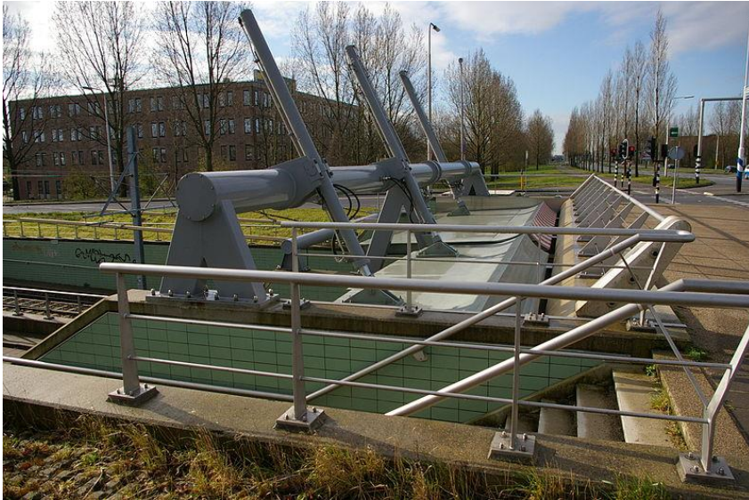
Figuur 5.5 Sluitbare waterkering in Amstelveen
