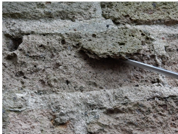
Figuur 2: aantasting oppervlak tufsteen
