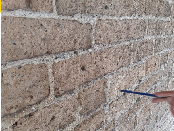
Foto 1 (afgeschilferd tufsteen)
