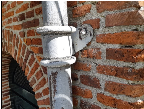
Foto 5 (gescheurde ophangstrop)
