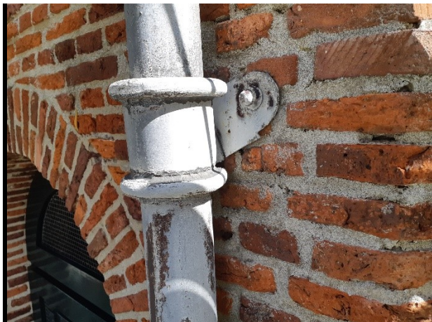
Foto 5 (gescheurde ophangstrop)
