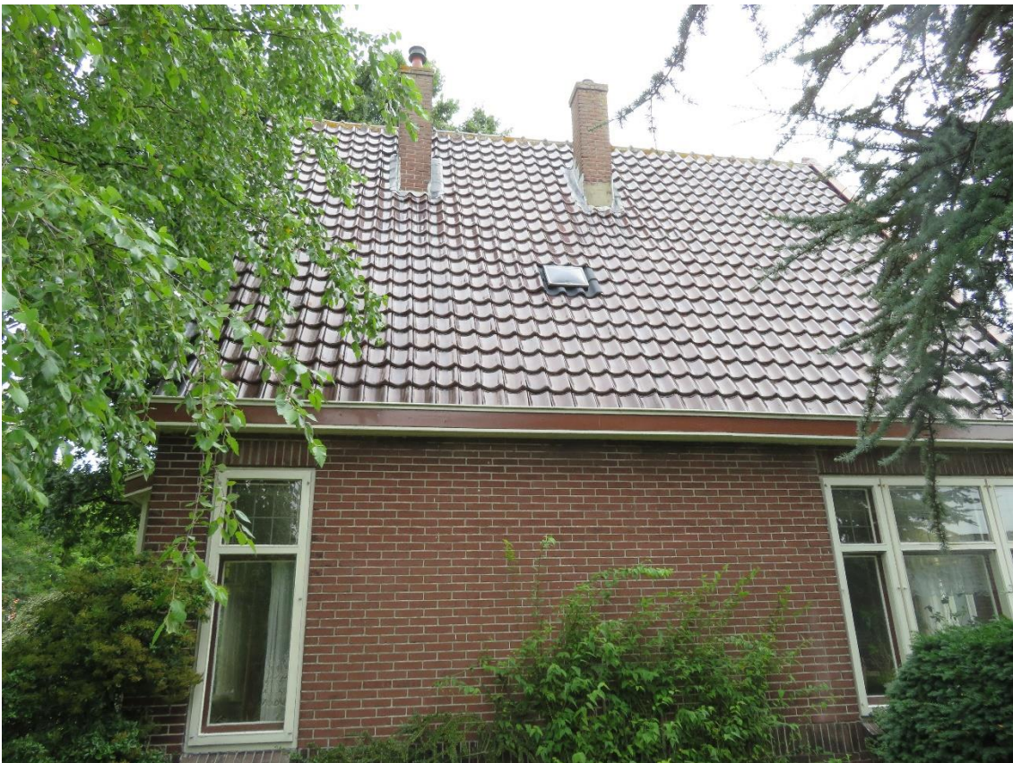
Goed sluitende pannen van het woonhuis.
