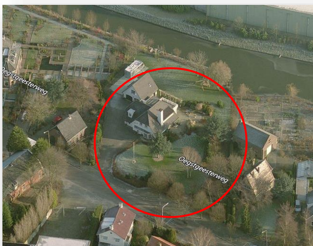
Afbeelding 1: Plangebied gelegen aan de Oegstgeesterweg, bron: Bing
