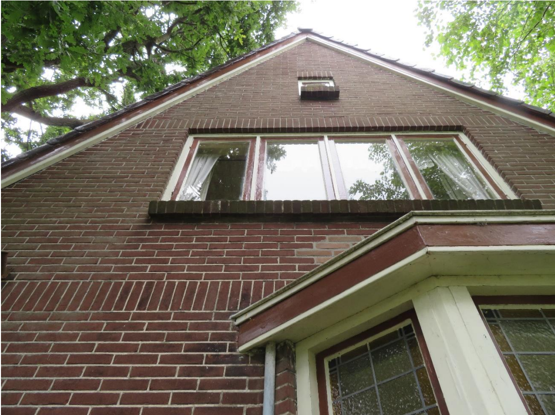
Voorgevel woning. De kantpannen sluiten goed aan. Oeningen in de gevel zijn niet aanwezig.
