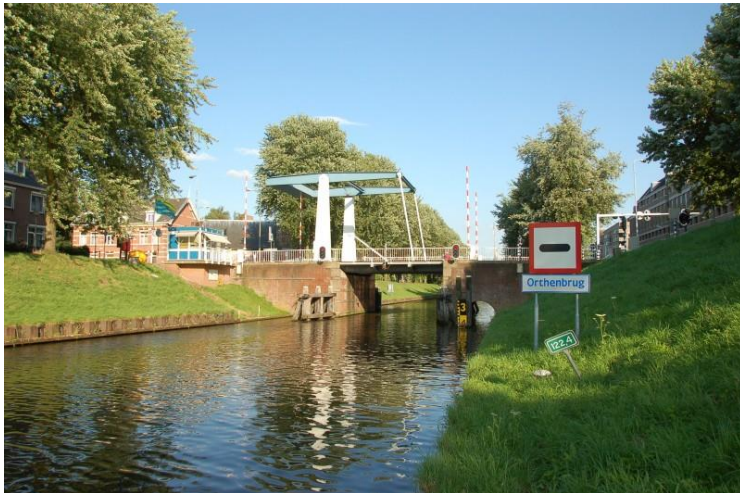
Afbeelding 4.5 Zicht op de Orthenbrug. Bron: [ref. 11]
