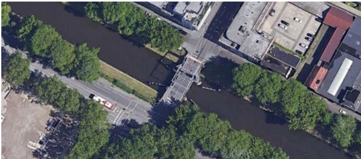
Afbeelding 4.4 Bovenaanzicht van de Kasterenbrug. Bron: Google Earth
