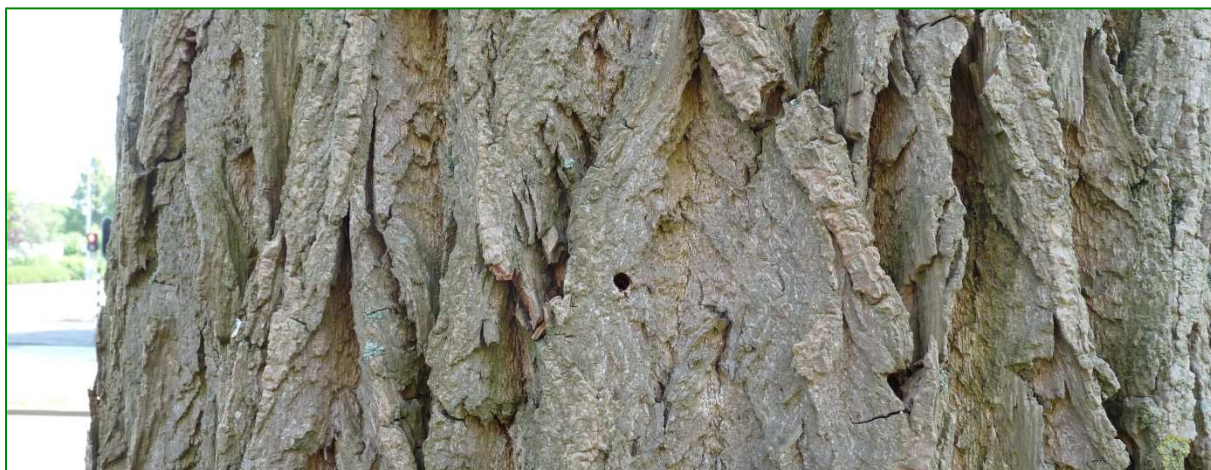
Afbeelding 4: Uitvlieggat bij boom 23 op 1,5 meter boven maaiveld
