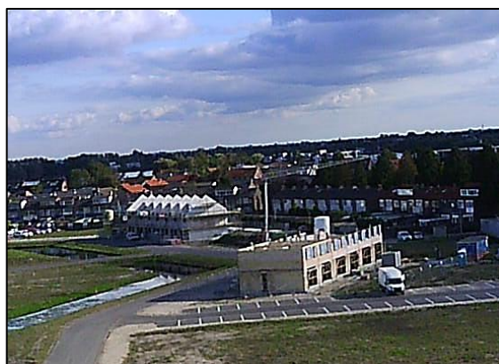
Figuur 8 Figuur 25 Woonwijk in aanbouw (Vivero, Langeraar)
