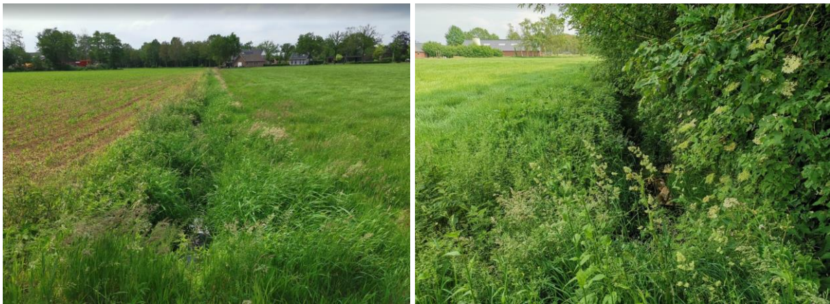
Afbeelding 2. Foto waterloop WL00820, links: situatie benedenstrooms mogelijke locatie stuw (zie afbeelding 1), rechts: mogelijke locatie stuw, ter hoogte van gebouw op de achtergrond (situatie: 3-6-'19)
