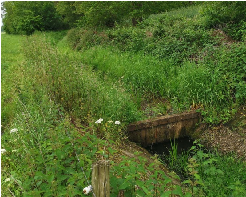
Figuur 3. Foto bestaande stuw ST01813 gefotografeerd vanaf de benedenstroomse zijde. Ligging stuw aan de westzijde in waterloop WL00721 (zie afbeelding 4)
