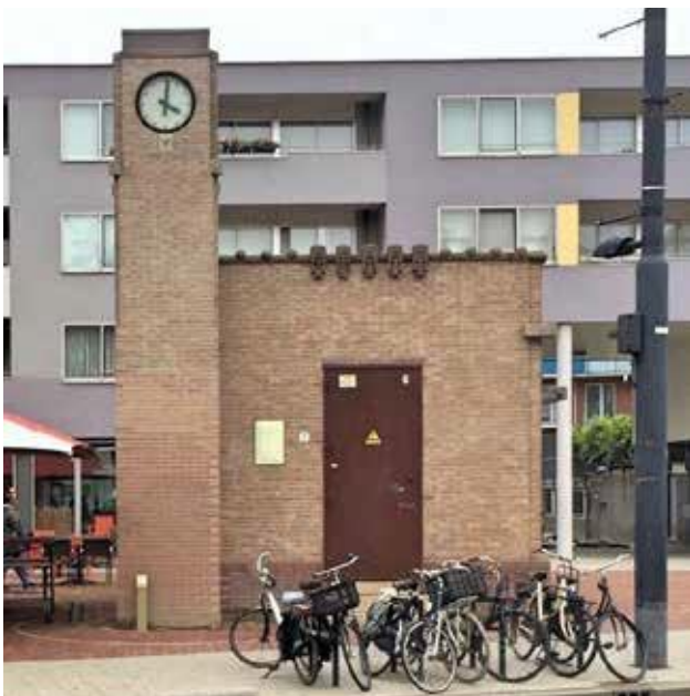
De trafo als architectonisch uniek object
