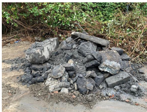
Foto 6: puin uit een inspectiesleuf
