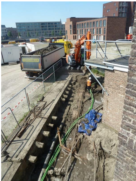
Foto 1 sleuf ten behoeve van werkzaamheden 2020
