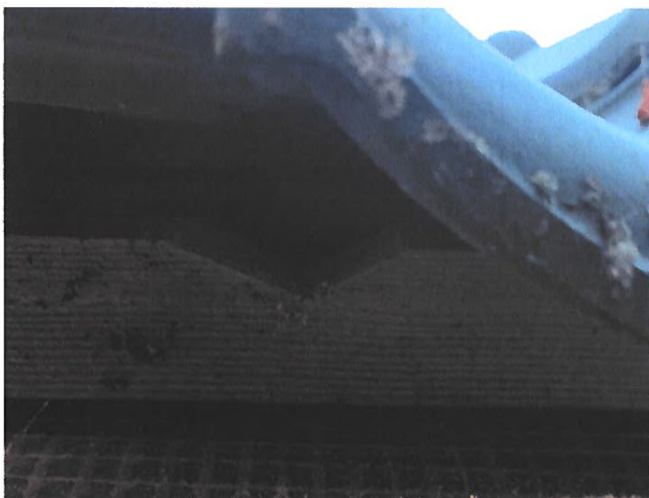
Extra openingen gerealiseerd onder het dak van de schuur
