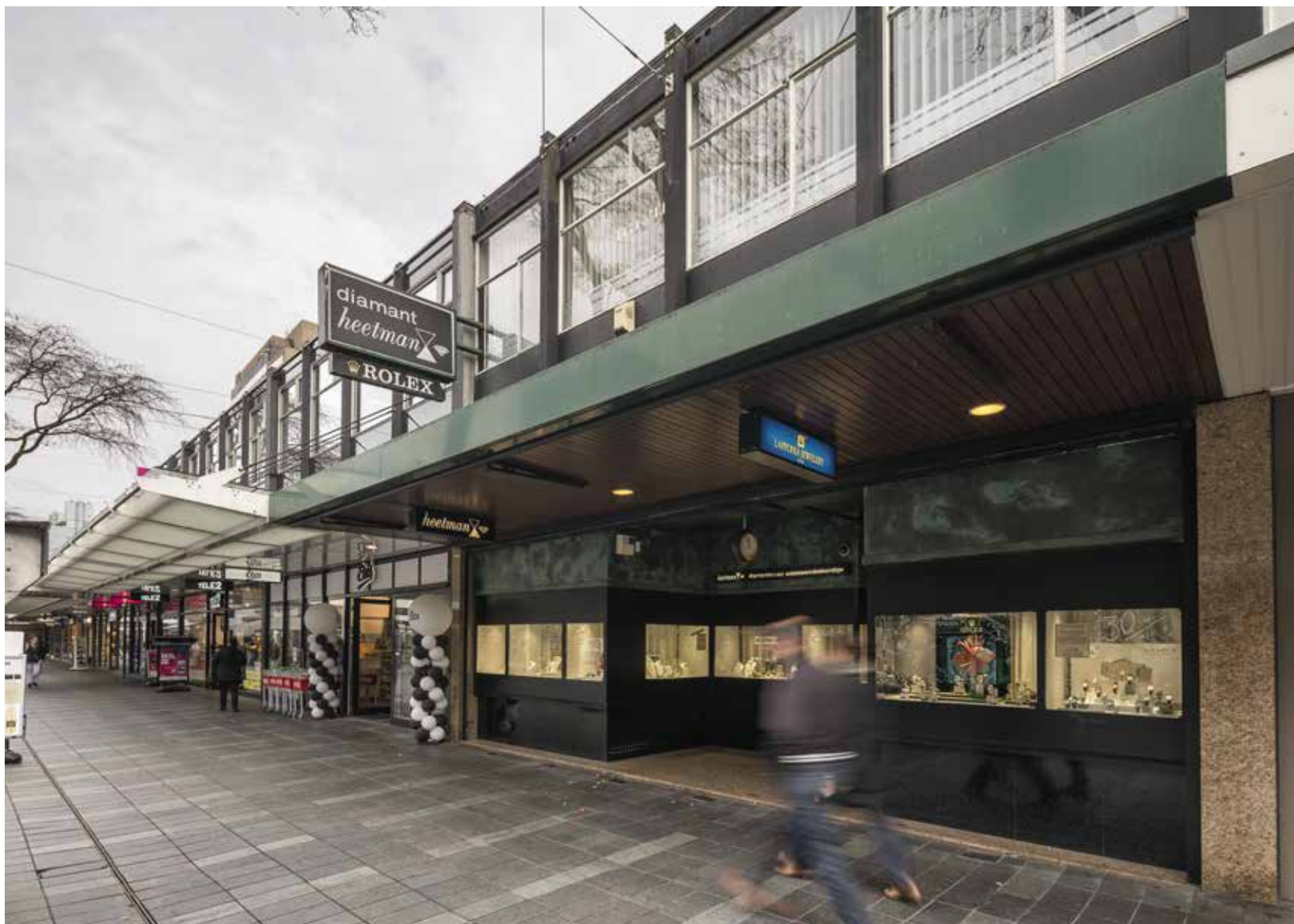
Bestaande situatie van Lijnbaan 92, voor verwijdering gevel
