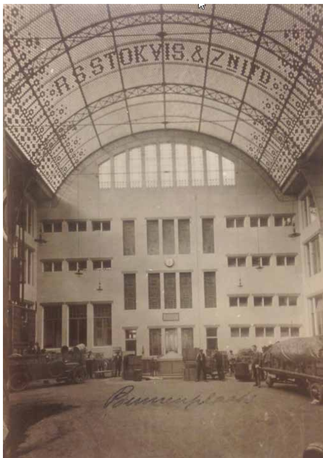
Restauratie glaswerk Oceaanhuis, Rotterdam
