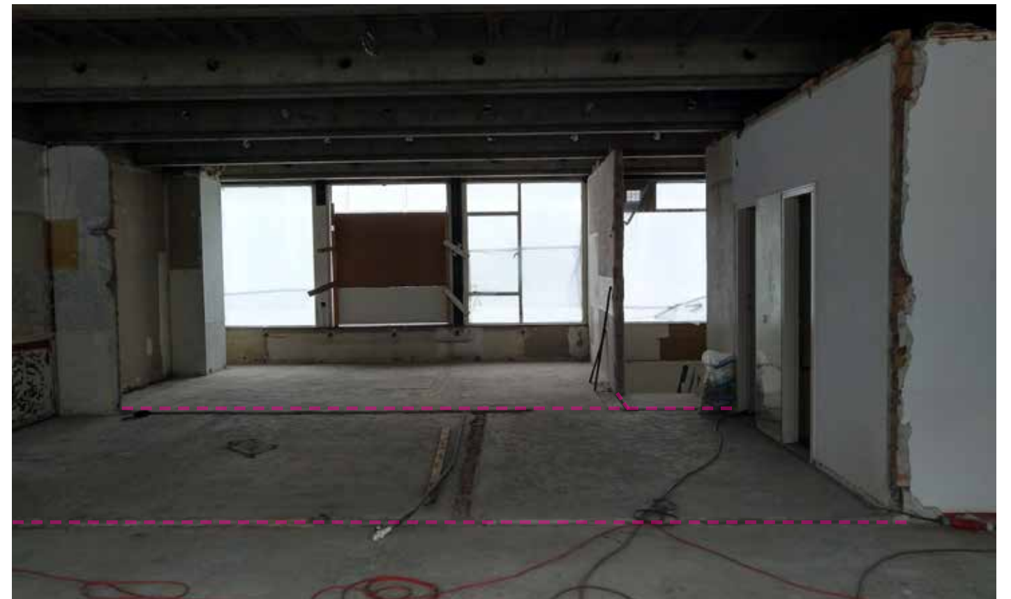
1e verdieping na verwijdering interieur
