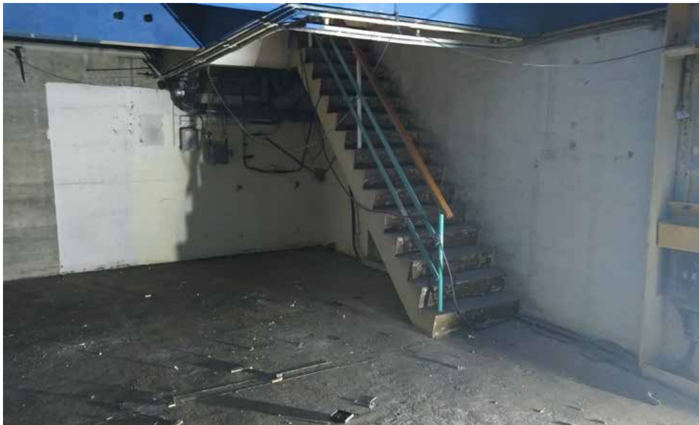
Betonnen trap naar begane grond
