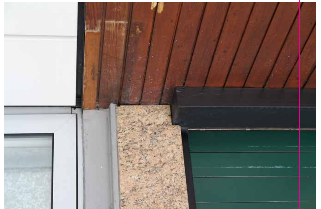
voorzijde luifel aangepast (groen zetwerk)
