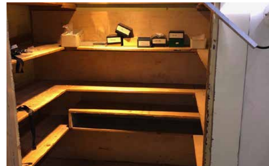
begane grond - voormalige betonnen kluis
