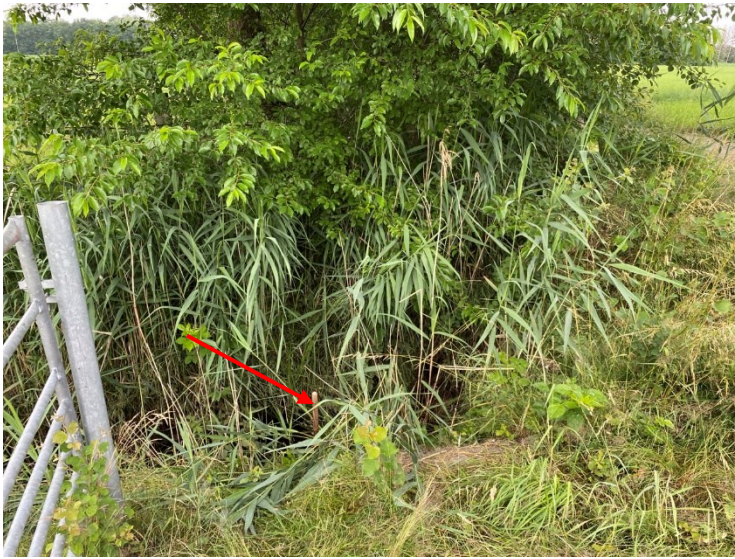
Figuur 8: foto Venbeek, ter plaatse van houten paal (zie rode pijl) komt een duiker uit op de Venbeek.
