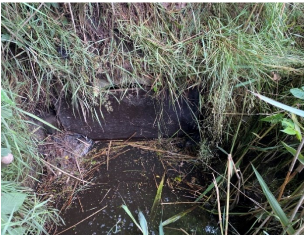
Figuur 7: foto huidige duiker Venbeek, waarop de stuw aangesloten wordt. Momenteel zit een schot met zandzak voor de duiker. Zijkant beek is voorzien van houtenbeschoeiing.
