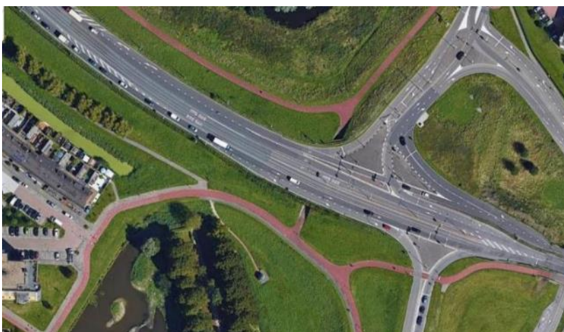
Figuur 12: bestaande situatie noordelijke oprit Algerbrug.
