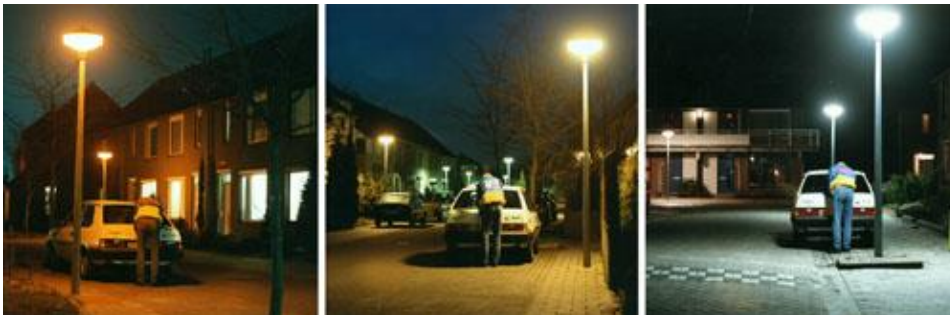
Figuur 6.1: Verschil in kleurtemperaturen en Ra-waarde van laag naar hoog en invloed op kleurherkenning. (Foto: Rien Valk)
