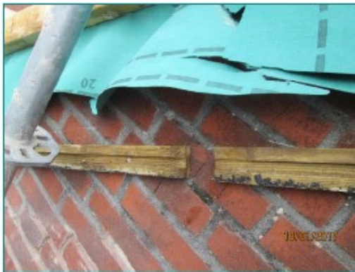
Figuur 4: Muurlatten voor bevestiging trespa boeibord met opening voor toegang vleermuizen achter boeibord. Folie wordt weggesneden.
