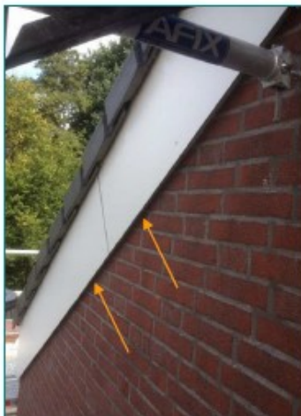
Figuur 6: Koppgevel met aangebrachte trespa boeibord. De pijlen geven enkele invliegopeningen voor vleermuizen weer in verschillende compartimenten.
