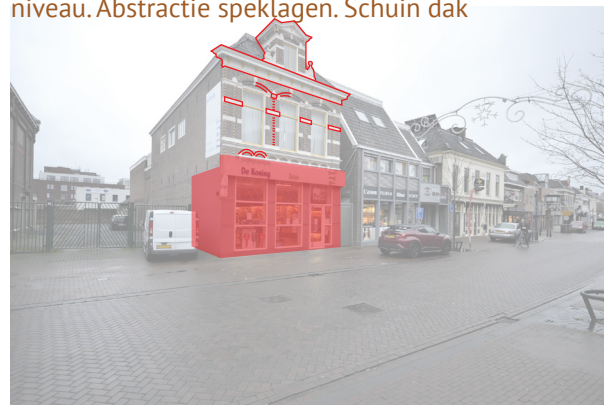
klassieke voorgevel rijk gedetailleerd. Schuin dak. Plint vaak verbouwd in andere stijl
