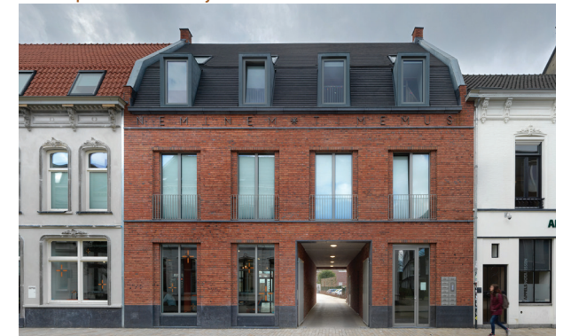
Gevelopbouw o.b.v. analyse context. Bijzondere neggen zorgen voor plasticiteit
