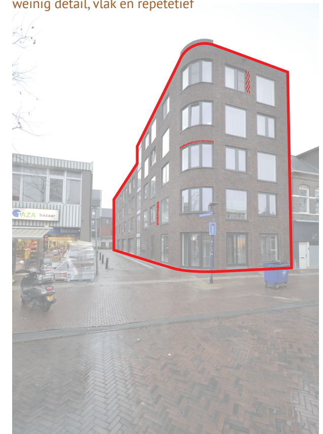
uniformiteit door repetetief bouwsysteem verbijzondering metselwerk
