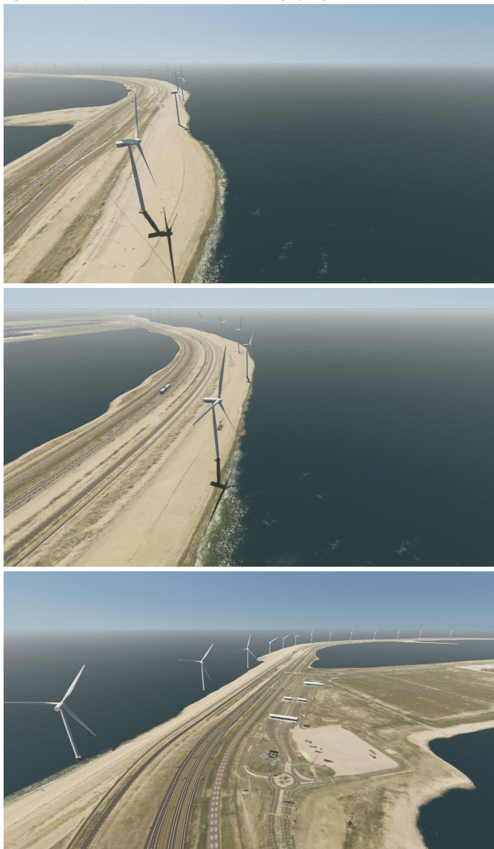
Figuur 13.14 Impressie windturbines zachte zeewering bij laag water
