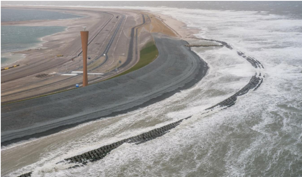
Figuur 3-1: harde zeewering met blokkendam en radartoren en de overgang naar de zachte zeewering
